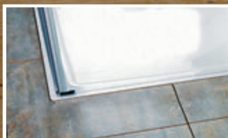
Einlassen in den Boden
