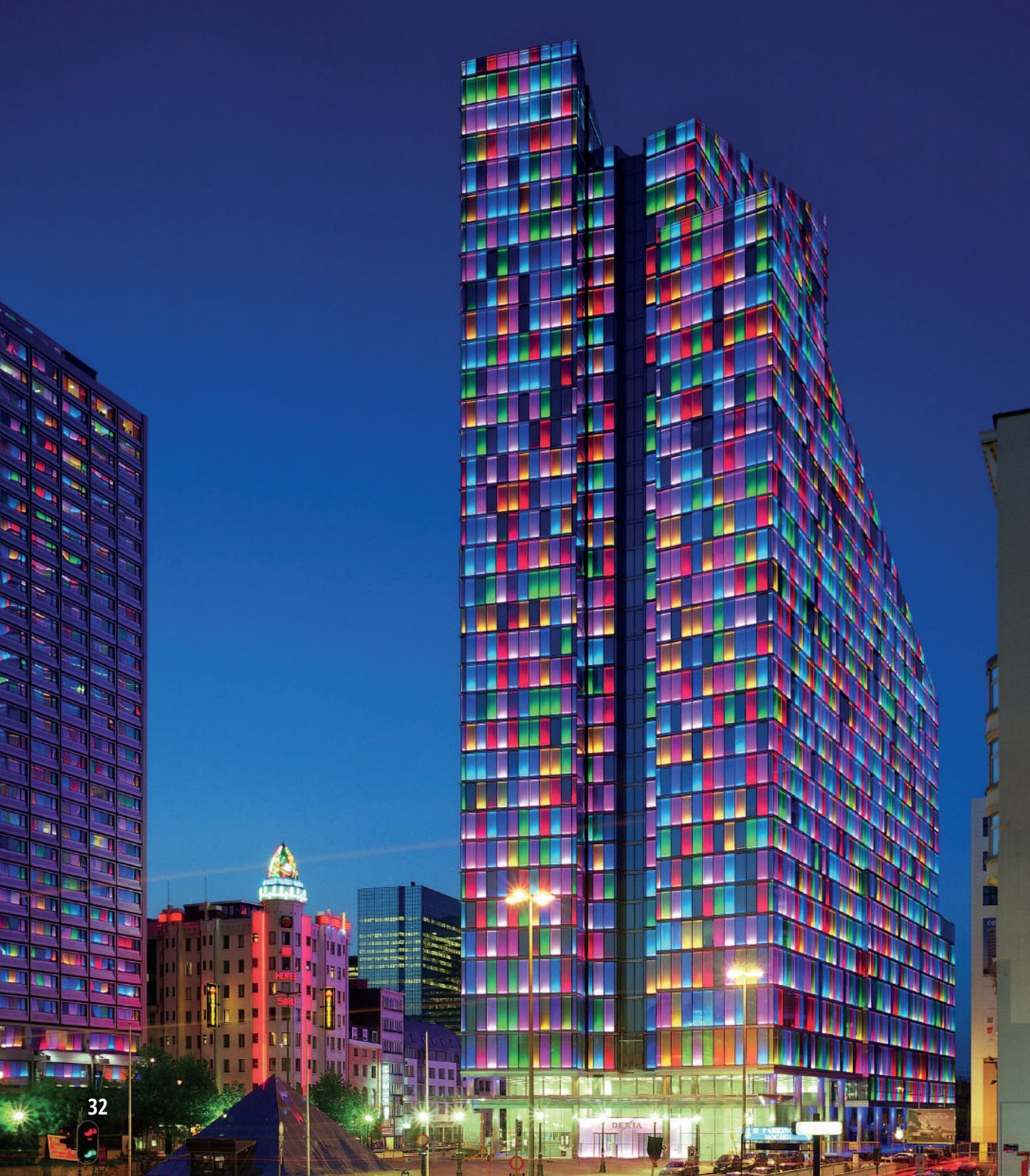
PALAZZO DEXIA - Bruxelles, Belgio DEXIA BUILDING - Bruxelles, Belgium
