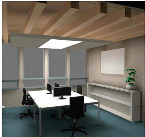
Für drei Arbeitsplätze wurde eine Klimaleuchte vorgesehen. Nach photometrischer Berechnung lässt sich mit ca. 110 W eine Ausleuchtung von >500 lx sicherstellen. Optional können mit 220 W >1000 lx eingestellt werden.
