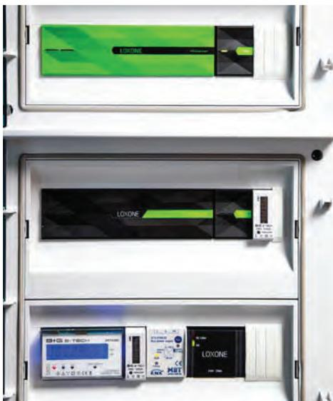
Schaltschrank mit Loxone Miniserver und Erweiterung, Energiezähler und DALI-Anbindung
