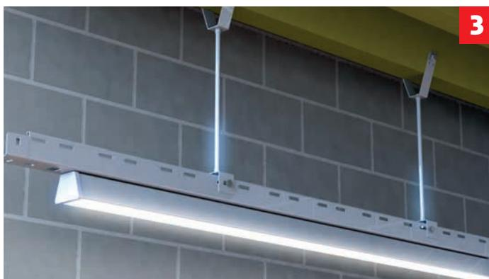
Montaža regala za rasvetu na trapezni plafon ostvaruje se pomoću nosača za trapezni lim, navojne šipke i nosača regala.
