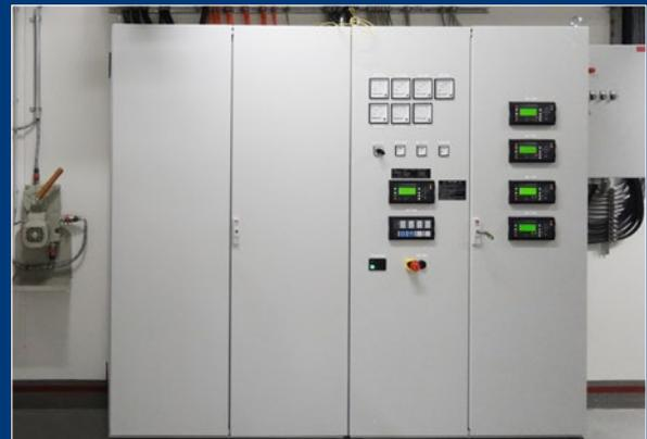
Schaltanlagen auch mit mehreren Steuerungen für mehrere Netze möglich, die durch ein Aggregat versorgt werden.
