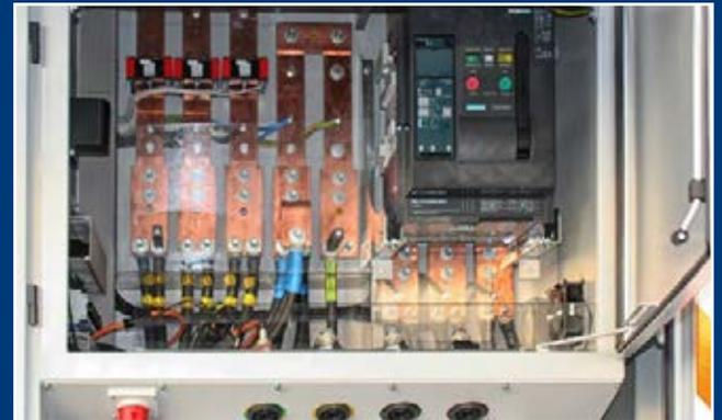
Der Leistungsteil ist serienmäßig mechanisch getrennt vom Steuerteil aufgebaut.
