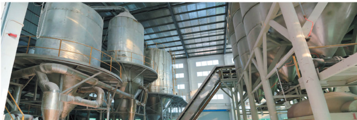
喷雾塔 Spray tower
