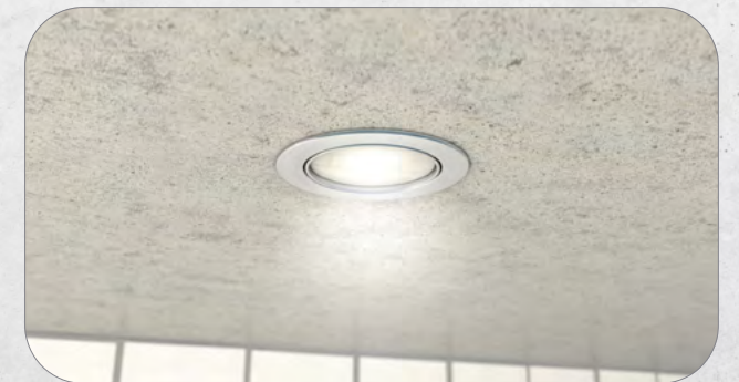
6. Beliebige Einbaugeräte wie z.B. Leuchten oder Lautsprecher installieren.
