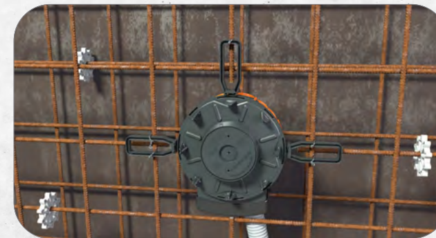
3. Für zusätzlichen Halt kann ein dritter Flügel montiert werden.
