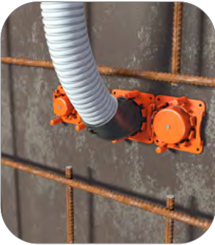
Frontteil auf Schalung nageln. Das Frontteil lässt sich durch das Stecksystem fest mit weiteren Krümmern und auch Tüllen verbinden. Krümmer auf das Frontteil stecken. Idealer Biegeradius von 30°.
