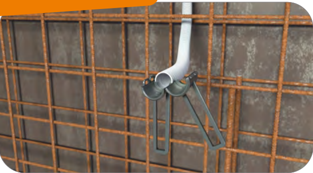
Tülle öffnen und Rohr M20 oder M25 befestigen. Dank 1-für-2-System können verschiedene Rohrgrößen kombiniert werden.
