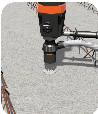
74 mm Bohrung in Filigrandecke einbringen.
