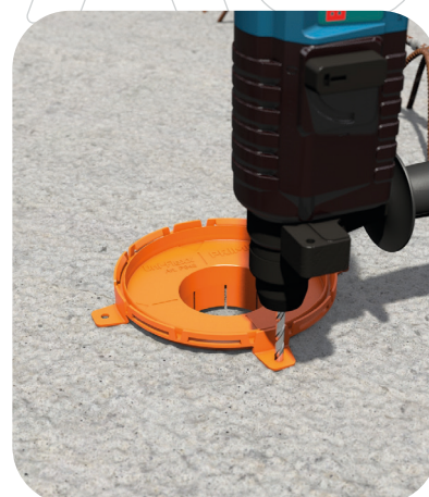
Uni-Flexx in Bohrloch stecken. Löcher durch Montagelaschen bohren und mit Schlagdübeln befestigen.
