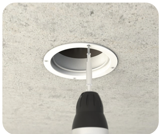
Adaptingring an Lüftungshülse anschrauben und Lüftungsauslass montieren. Dank genormter Schraubdoms kein Vorbohren notwendig.
