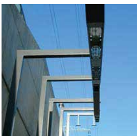
Stuttgart: station Eichwiesenring
