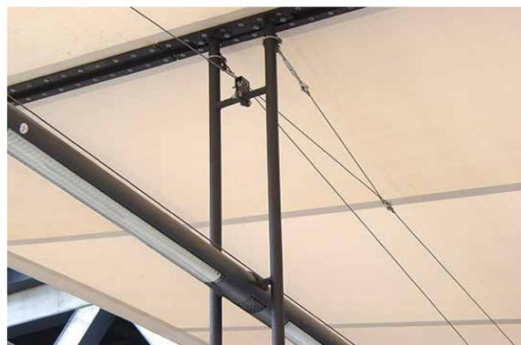
Beleuchtungsrohr am Bahnsteig
