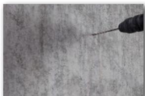
**1** Bohrloch Ø 6 mm.
