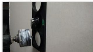
**3** Anschließend durch die vorhandenen Locheinsätze bohren.
