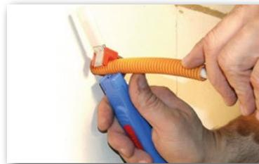
**2** Installationsrohr wandbündig abschneiden.
