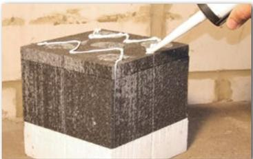
**4** TIE-Hybridkleber raupenförmig, dünn (5 - 6 mm) auftragen.
