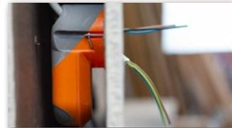
**3** Fertig. Die Dose ist eingebaut und der Biegeradius der Netzkabel wird problemlos eingehalten.
