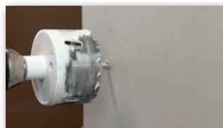
**5** In vorgegebenes Loch mit Zentrierbohrer der Fräskrone bohren; Dosenloch senken.
