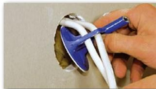
**5** Leitungsträger und Leitungen aus der Wand ziehen.
