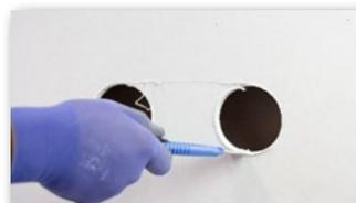
2 Mit Fräskrone Ø 68 mm die beiden äußeren Löcher senken und das Mittelstück mit Cutter oder Stichsäge ausschneiden.
