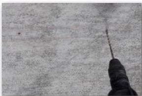
**1** Bohrloch Ø 6 mm.
