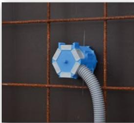
**5** Fertig, absolut sichere Zugentlastung!
