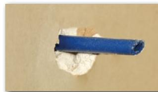
**3** Der Trockenbauer schlägt mit dem Hammer ein Loch aus und lässt den Mitteldorn durchstehen, dieser dient als Zentrierung für die Bohrkronen.
