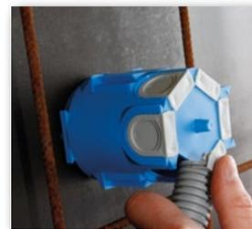
**4** Rohr mit Quick-Fix-Schieber einschieben und schließen.
