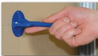
**1** Aufkleben des Leitungsträgers an der Rückseite der ersten Beplankung.
