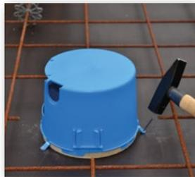
**2** Bei Ortbeton auf Schalung nageln oder Fertigteilwerk auf Schaltisch kleben.
