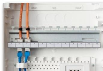
**2** Das im oberen Bereich integrierte Patchfeld ermöglicht Ihnen eine einfache Montage von Patch-Modulen im „Keystone-Format“.
