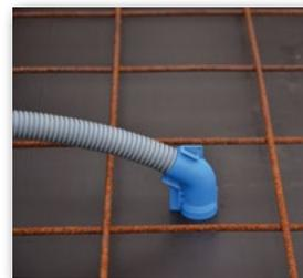
**4** Auf das Unterteil stecken. Absolut sichere Zugentlastung!
