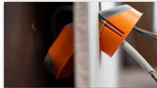
**2** Durch die flexible Membran wird die Dose einfach und bequem in die Hohlwand eingeführt.
