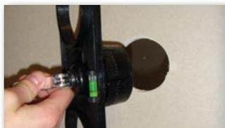
**1** Bohren des mittleren Loches.
