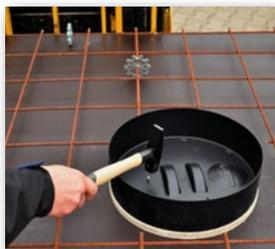
**2** Bei Ortbeton auf Schalung nageln oder im Fertigteilwerk auf den Schaltisch kleben.
