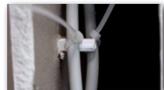
**3** Kabel mit Kabelbinder an f-fix befestigen.
