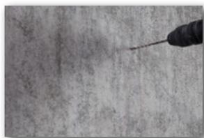
**1** Bohrloch Ø 6 mm.
