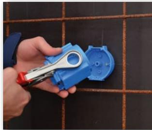
**2** Rohr- oder Kabeleinführung mit der Stanzzange ausstanzen.
