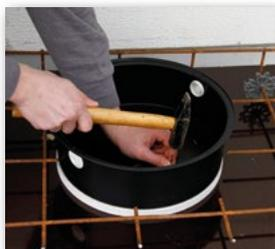
**2** Bei Ortbeton auf Schalung nageln, im Fertigteilwerk auf Schaltisch kleben.
