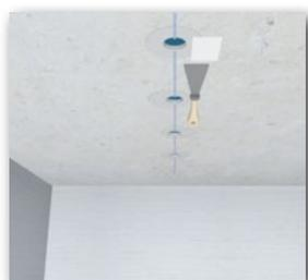
**2** Mit einem Lochsneider wird die individuelle Öffnung ausgebohrt und an die Mineralfaserplatte angespachtelt.
