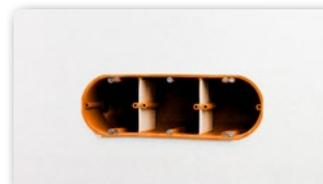
3 Dose einsetzen und mit Befestigungsschrauben fixieren.
