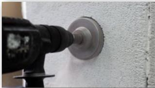
**1** Mit Fräskrone die Wand vollständig durchbohren.
