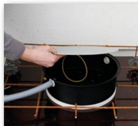
**3** Rohre/Kabel einführen und stabile Blechplatte mit Kabelbinder befestigen.
