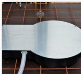
**3** Oberteil einfach aufstecken – Armierung verläuft unter der Dose, keine Einschränkung der Statik.
