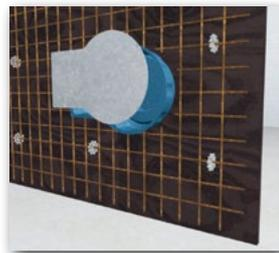
**2** Deckel mit beiliegenden Kabelbindern befestigen.
