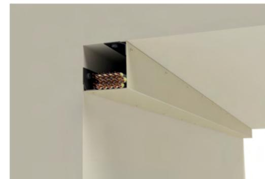
Einsatz des Kanals in zweiseitiger Ausführung (L-Form), hier gezeichnet mit versteckten innenliegenden Befestigungslaschen. Ideal auch als Steigepunkt in Treppenhäusern mit jederzeit möglicher Öffnung für Nachbelegungen.
