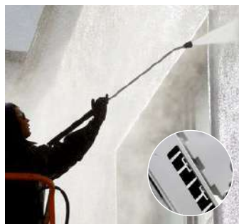
Limpieza de alta presión High-pressure cleaning Nettoyage à haute pression
