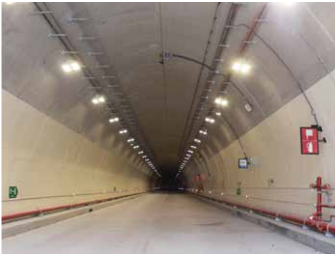
Túnel Mulatos: 2,5km – COLOMBIA
