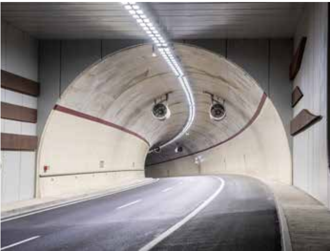
Túnel Caldearenas: 3km – SPAIN
