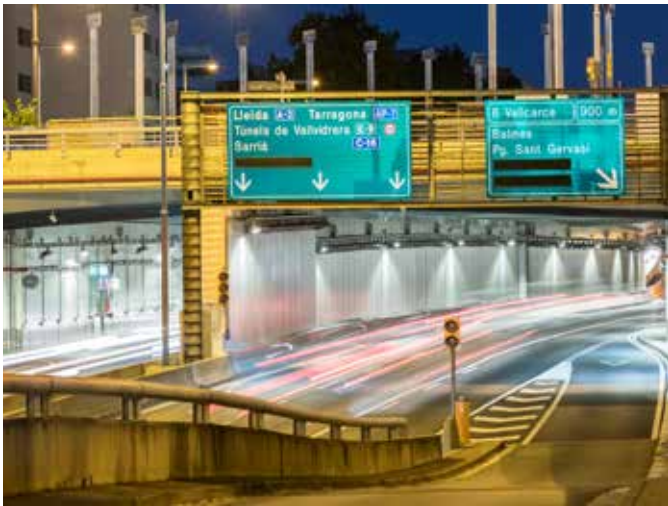
Túnel Vall d'Hebron – SPAIN
