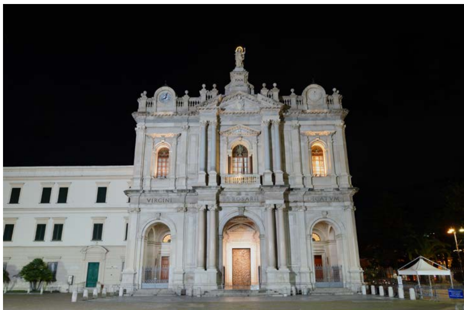
Facciata frontale del Santuario
