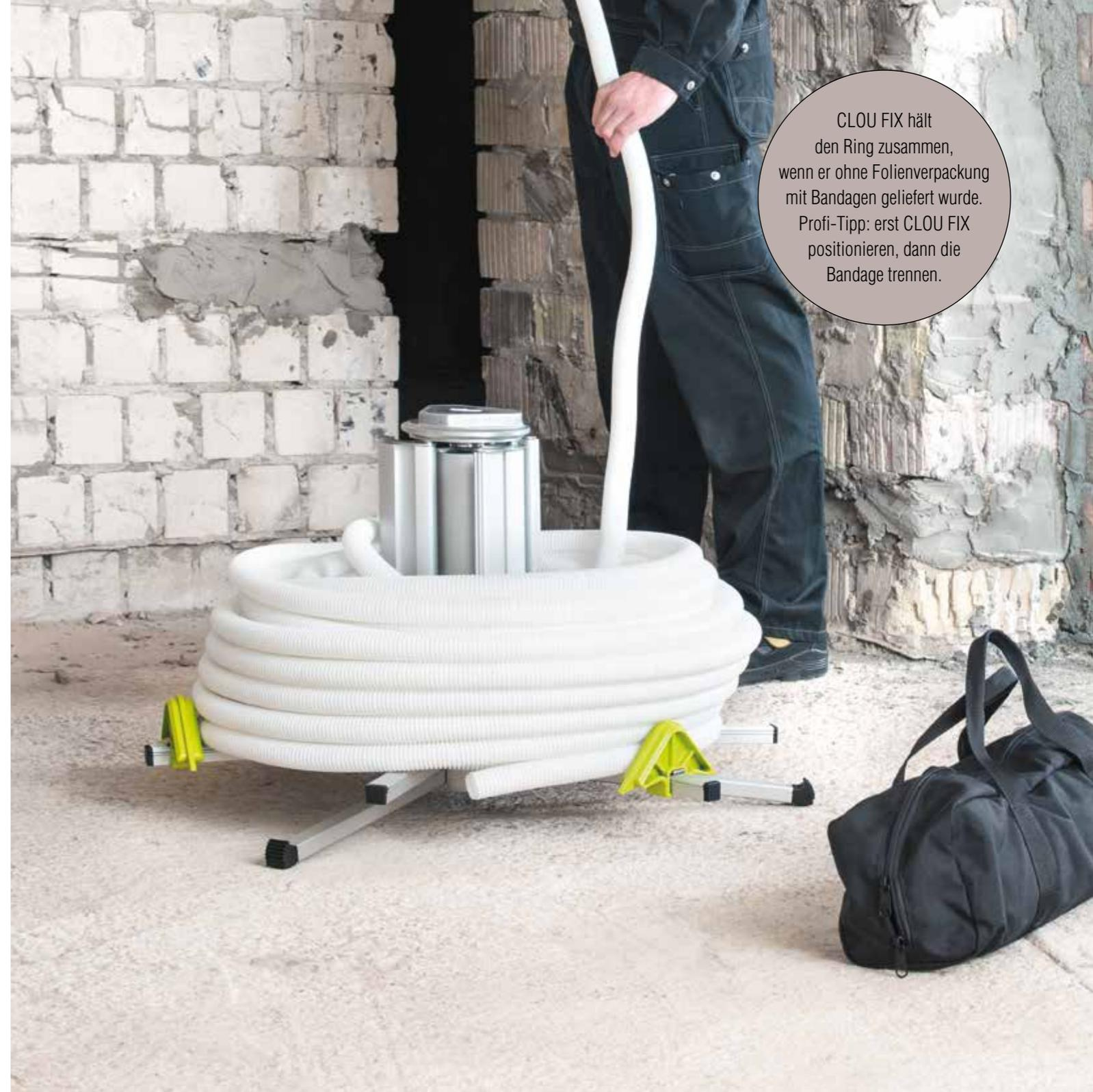
CLOU FIX hält den Ring zusammen, wenn er ohne Folienverpackung mit Bandagen geliefert wurde. Profi-Tipp: erst CLOU FIX positionieren, dann die Bandage trennen.
