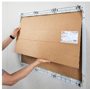
15 Zuverlässiger Schmutzschutz nach der Elektroinstallation
