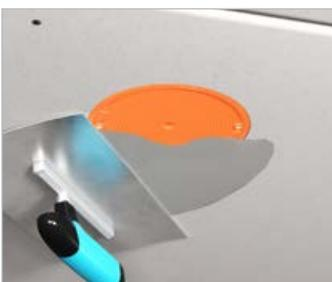
Überspachteln des montierten Einbaugeschäuses mit handelsüblicher Spachtelmasse.
