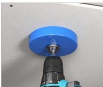
Einbauöffnung Ø 120 mm mit KAISER Bi-Metall-Fräser (Art.-Nr. 1082-20) erstellen.
