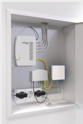
Der innovative Glasfaser-Teilnehmeranschluss (Gf-TA) besteht durch eine kompakte Bauform von nur 16 mm Aufbauhöhe. Das schlichte Design wurde speziell für die optimale Anpassung im Wohnbereich gewählt.
