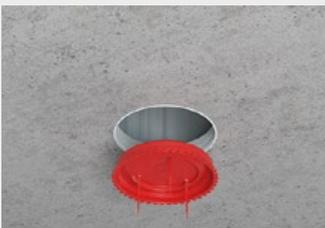
Nach dem Ausschalen und dem Einziehen der Versorgungsleitungen wird der Signaldeckel in die Einbauöffnung eingesetzt.
