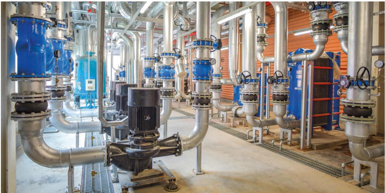
Abb. 60: Wärmeaustauschstation
