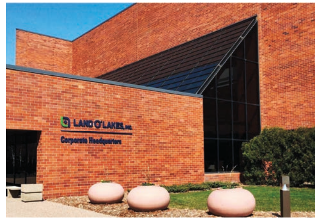
Abb. 58: Bürogebäude, Nachrüstung und Energieeinsparung von 15%.
