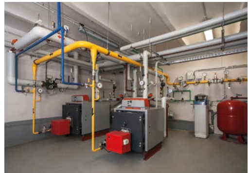
Abb. 113: Gasbrennwertkessel
