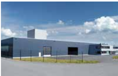
Eibach Wiethfeld, Nähe Finnentrop, Deutschland | Eibach Wiethfeld Plant, near Finnentrop, Germany
