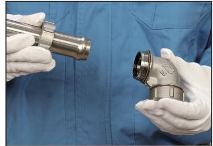
**6.** Stecken Sie das verlängerte Rohr in das Anschlussstück und ziehen Sie die Hutmutter fest an.
