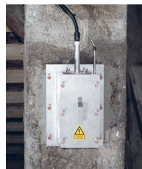
4. Elektrische Verbindung zur Steuerung herstellen
