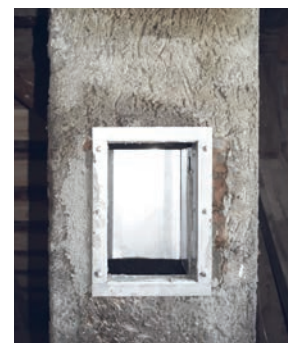
2. Einputzrahmen einmauern
