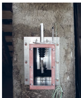
3. Abscheider an Einputzrahmen befestigen
