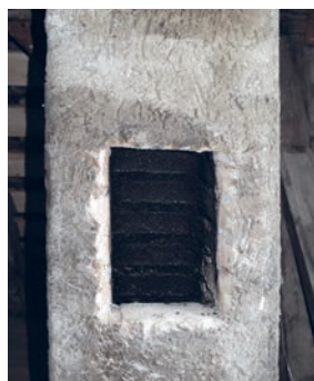
1. Öffnung in bestehenden Schornstein stemmen
