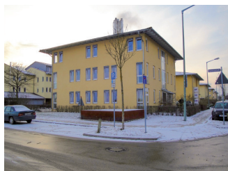
Fernheizwerk Ismaning D-85737 Ismaning
