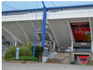
Grundig Stadion FC Nürnberg D-90471 Nürnberg
