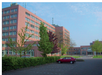
Landratsamt Steinfurt D-48565 Steinfurt
