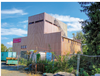
Fernheizwerk Wächtersbach D-63607 Wächtersbach
