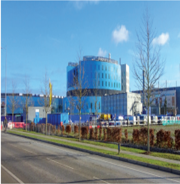
Planung Enerplan GmbH Ausführung Enercret GmbH
