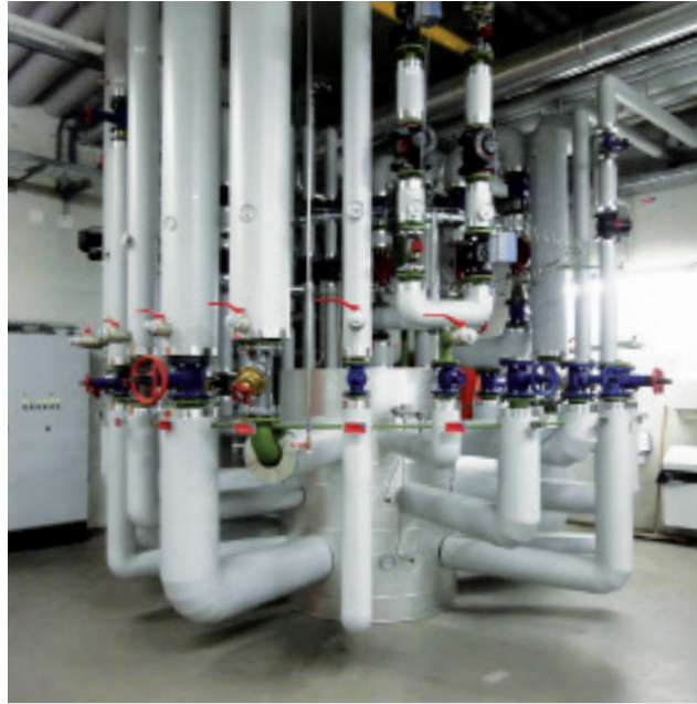
Zortström Multi-H 3-stufig Durchmesser 800 mm
