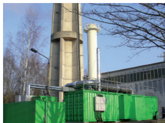
Fernheizwerk Hohenstein D-65329 Hohenstein
