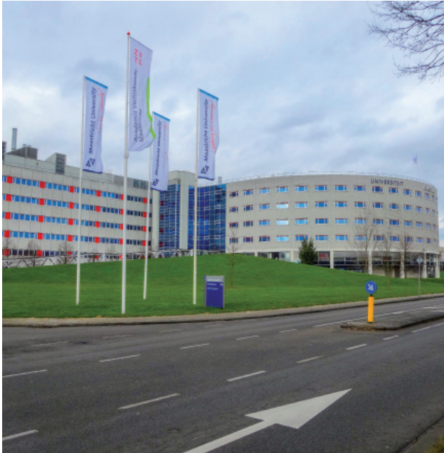
Planung Royal HaskoningDHV Ausführung Academisch Ziekenhuis Maastricht
