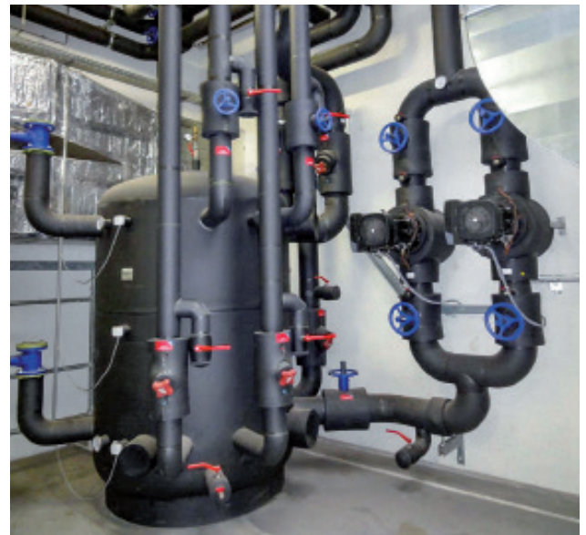
Zortström Multi-PG-K 3-stufig Durchmesser 1.100 mm
