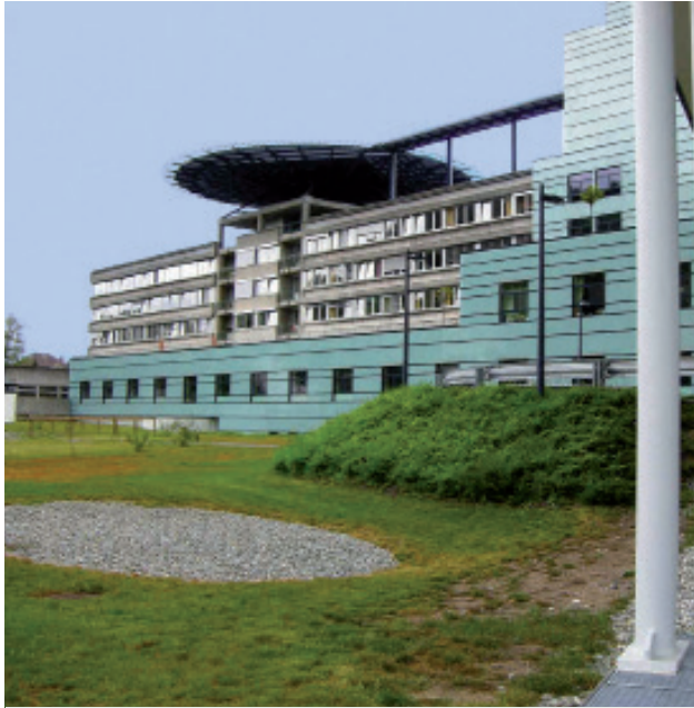
Planung Hightech-Büro Linher Ausführung Intemann GmbH
