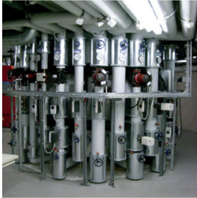
Zortström Multi-H 4-stufig Durchmesser 1.200 mm
