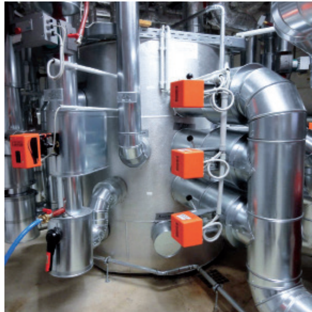
Zortström Multi-K 4-stufig Durchmesser 1.100 mm
