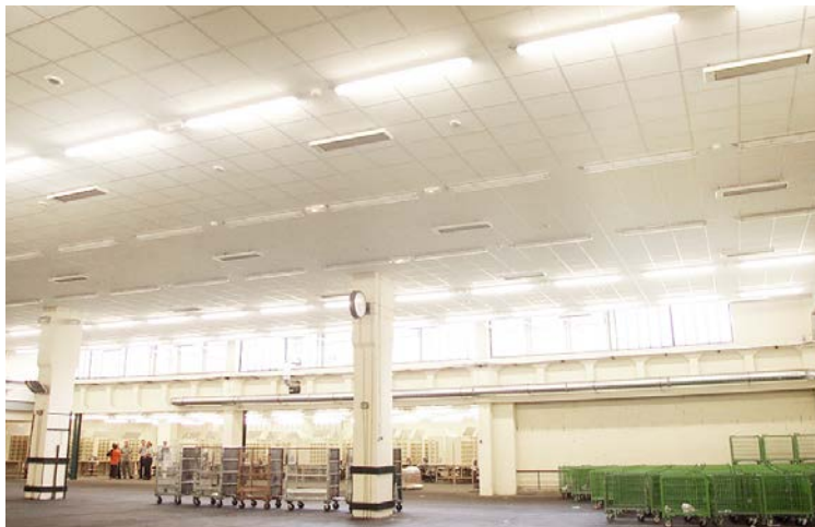
Wärmestrahler geben die Wärme an Oberflächen wie Personen, Böden und Einbauten ab. So wird auch in Räumen mit großem Volumen ein angenehmes Raumklima erreicht.
