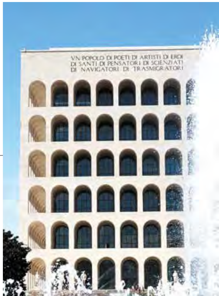
FONDAZIONE FENDI - PALAZZO DELLE CIVILTÀ ROMA ITALY - 2014 Heating/cooling system
