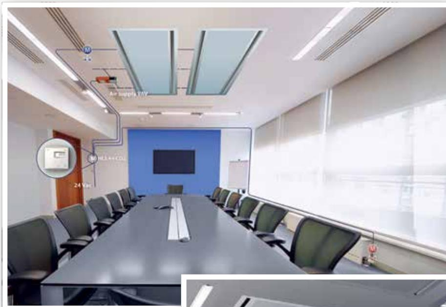
In Konferenzräumen kann HLS 44-CO2 (Seite 28) Kühlkonvektoren mit Kühlung und einen Klappenantrieb für die Belüftung steuern, wenn die CO<sub>2</sub>-Werte zu hoch sind oder wenn Kühlung erforderlich ist. Die Heizung wird mit Heizkörpern geregelt.
