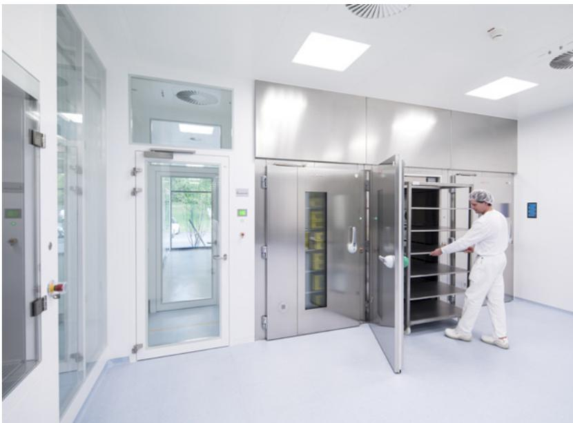
HVS (high velocity streaming) Horizontal-Flow-Kühlschleusen zur kontrollierten Abkühlung von Ernährungslösungen mit integrierten Temperatur- und Druckmonitoring
