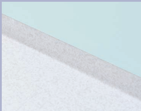
Wannenförmige Verlegung und thermische Verschweißung
