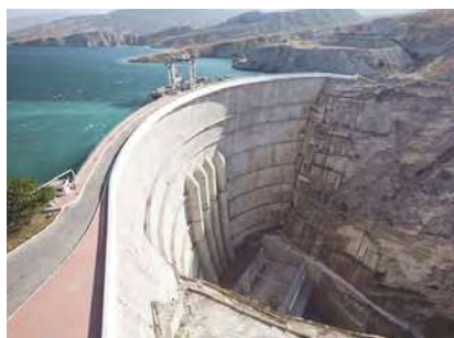
Impianti energetici Energy plants
