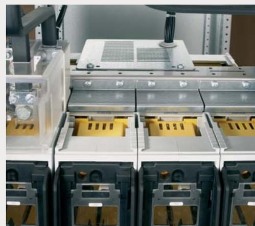
**Anschlussfertige, stahlblechgekapselte Niederspannungs-Schaltanlage in Schrankbauform in freistehender Ausführung als Energie-Schaltgerätekombination (PSC) nach DIN EN 61439 Teil 2**
