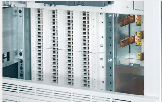
Nach dem Ausbau der Schaltgeräte ist das Verteilschiensystem berührungssicher abgedeckt (IP XXB).
