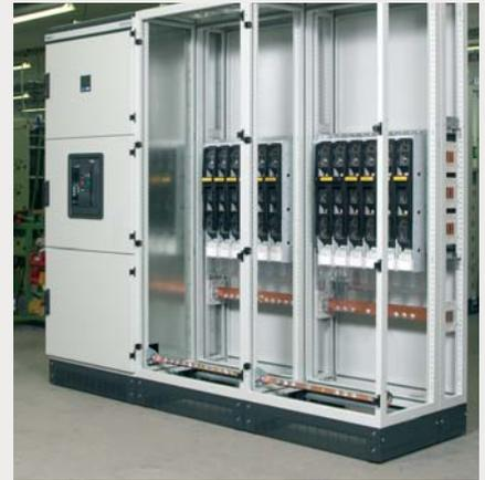
Die elektrische Energie fließt über das **Hauptsammelschienensystem** direkt und auf kurzem Weg zu den Schaltgeräten.
