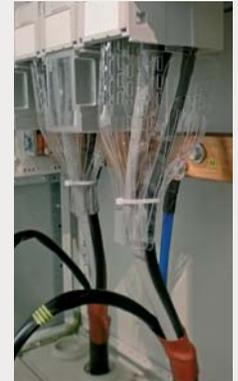
Eine Kabelanschlussraumabdeckung, die nach dem Anschluss der Kabel angebracht werden kann, bringt einen sicheren Berührungsschutz beim nachträglichen Anschluss von Kabeln.
