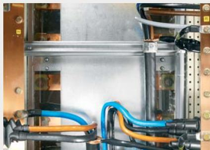
Die N (PEN)- und PE-Anschlussschienen werden EMV-günstig aufgebaut.
