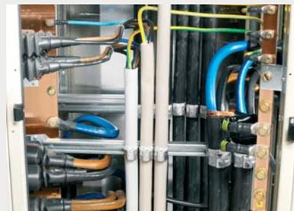
Der Einsatz von Kabelabfangschienen in zwei Ebenen ermöglicht die Fixierung auch einer größeren Anzahl von Abgangskabeln.
