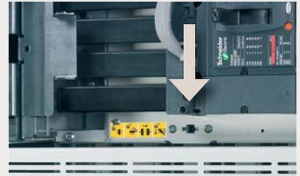
Der Zugang zur Verriegelungsmechanik ist bei jeder Schalterstellung zugänglich. Beim Entriegeln des Steckmoduls wird der Schalter automatisch ausgelöst.
