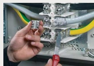
1. Das abisolierte Leiterende muss sorgfältig durch Schaben, zum Beispiel mit einem Messer, von der Oxidschicht gesäubert werden. Dabei dürfen keine Feilen, Schmirgelpapier oder Bürsten verwendet werden.
