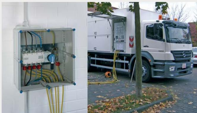
Netzumschalter (I-0-II) schalten sicher auf Ersatzstromquellen
