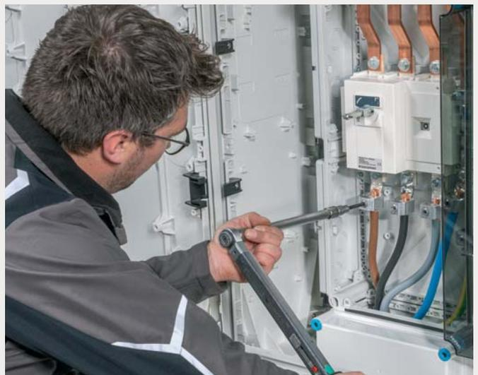
Die richtige Kontaktkraft spielt bei Klemmen eine elementare Rolle. Der Kontakt ist sicher, wenn eine gute Verbindung und ein sicherer Stromübergang an einer bestimmten Stelle mit vorgegebener Kraft durch optimales Drehmoment gewährleistet ist. Nur das richtige Drehmoment gewährleistet zuverlässige Klemmverbindungen! Ein zu hohes Drehmoment zerstört die Federwirkung der Klemme. Dies führt zu einem erhöhten Übergangswiderstand und somit zu einer starken thermischen Belastung der Klemmverbindung.
