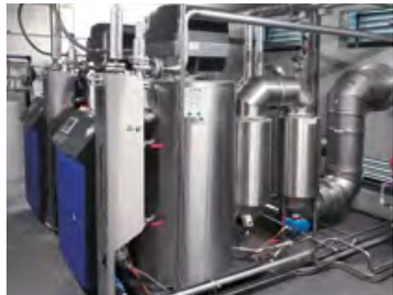
Abb.: Mehrfachdampfananlage mit zweitem Economiser auf Grundgestell
