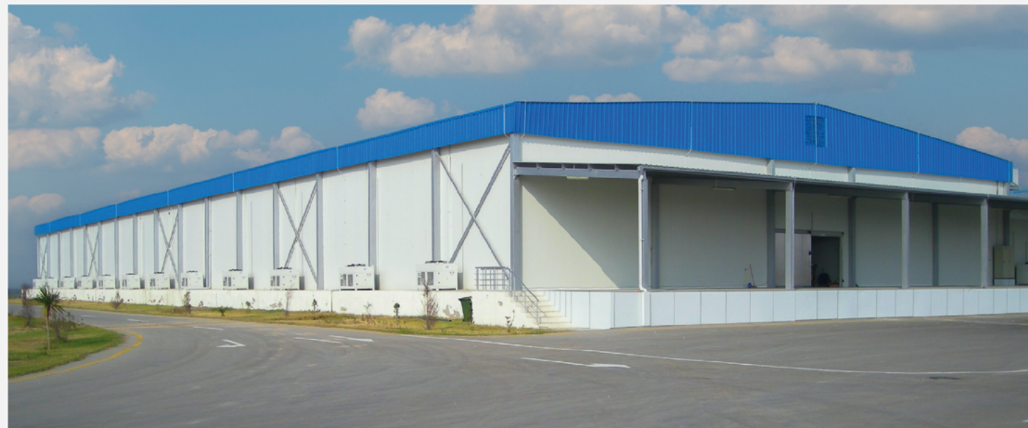
TURNKEY INDUSTRIAL REFRIGERATION PLANTS / Завод промышленного охлаждения под ключ
