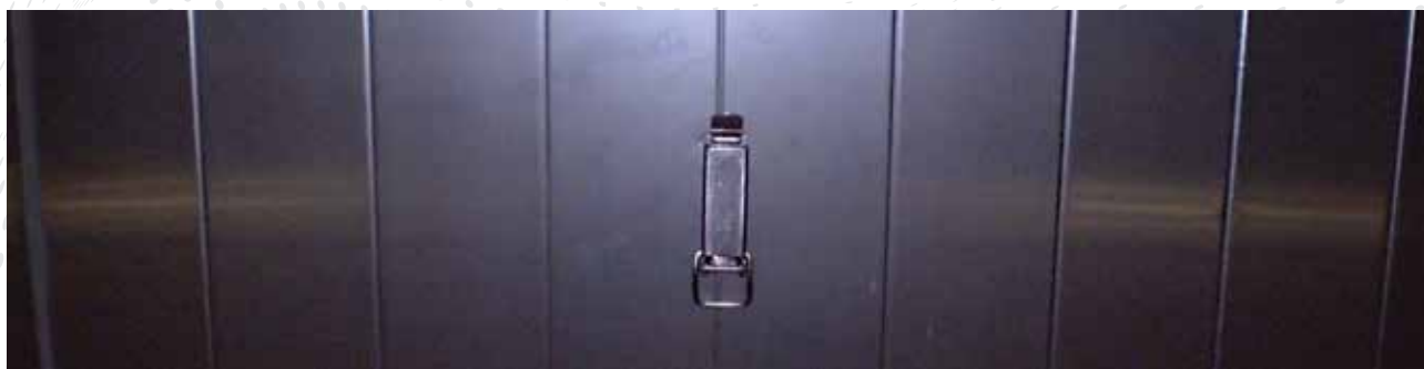
Fuge mit einzelem Verbindungselement bei Metallschalen
