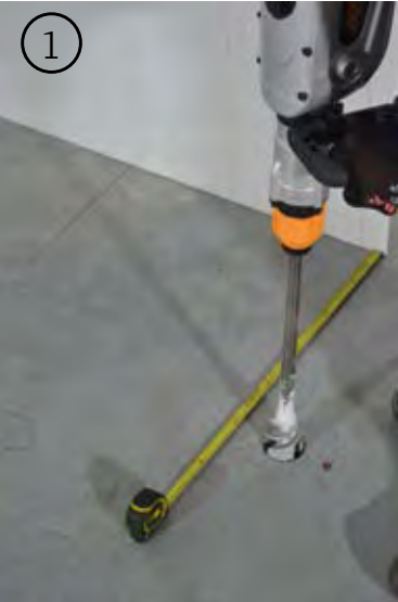
Medición y perforado Measuring and drilling
