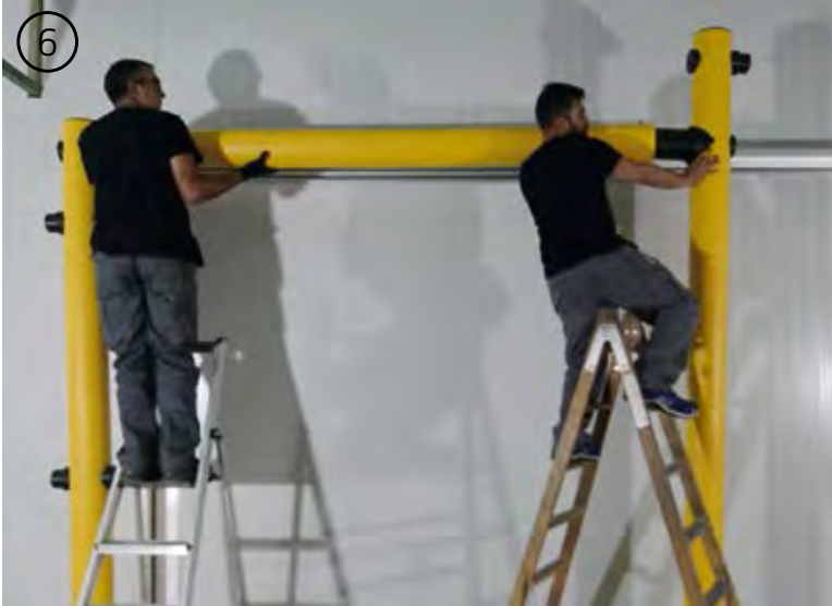
Introduccir dintel Crossbar placement
