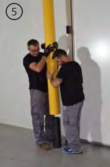
Introduccir jamba Post placement
