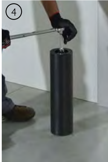
Fijación bolardo Bollard fixing
