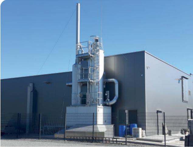
Abb. 3: Die zentrale Abluftfilteranlage entsorgt die Abluft der kombinierten angeschlossenen vier klassischen Kaltrauchanlagen und drei Heißrauchanlagen gemeinsam.
