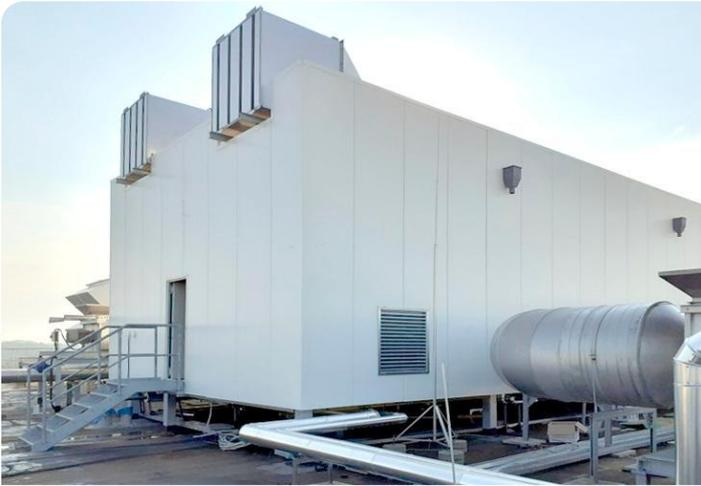
Im Wetterschutzgehäuse auf dem Hallendach ist die zentrale Filteranlage positioniert.
