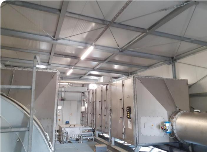
Zwei Abluftfiltersysteme für ein Gesamtabluftvolumen von 60 000 m<sup>3</sup> reinigen die geruchsbeladene Abluft und gewinnen Prozessabwärme zurück.
