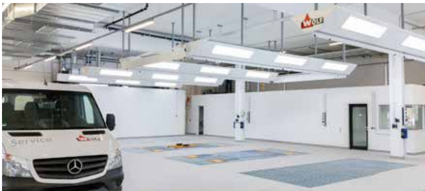
Vorbereitungsplätze mit LED-Beleuchtungsbalken mit integrierten Rollos
