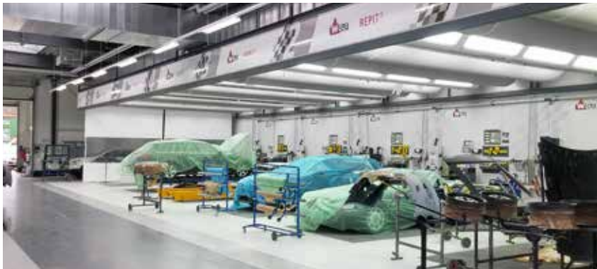
Spot-Repair Anlage: Floor System mit Beleuchtungsbalken, Trennrollos, je Platz 2 textile Zuluftkanäle
