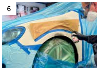
6 Mit 2K Säure-Primer grundieren (2 dünne Spritzgänge)
