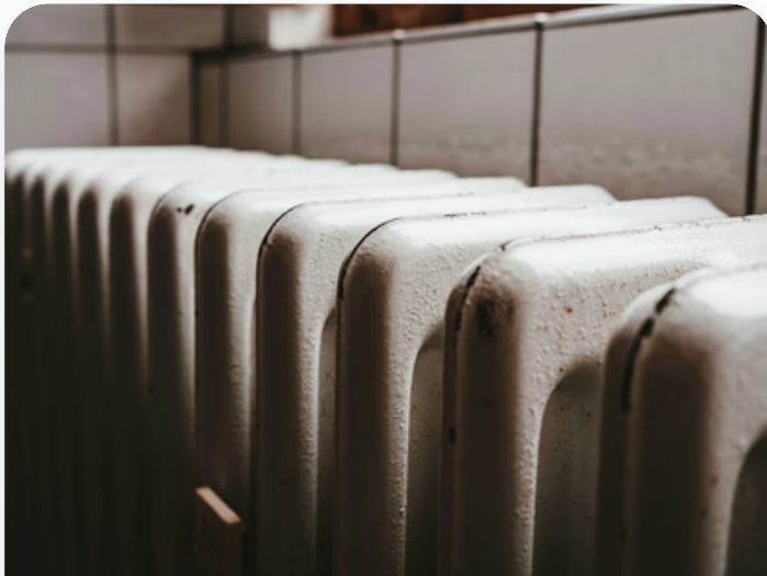
Heizungsstörung mit Notdienst
