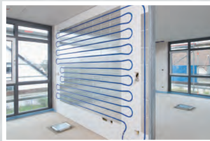
Wandheizung im Neubau eines Bürogebäudes
