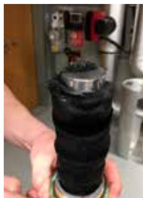
IMI Pneumatex Ferro-Cleaner filtert den Volumenstrom und entfernt mit einem sehr starken Magneten feinste Magnetitpartikel aus dem Anlagenwasser. Der N 40 H Neodym - Fe - Bor Magnet ist einer der stärksten Dauermagnete auf dem Markt.
