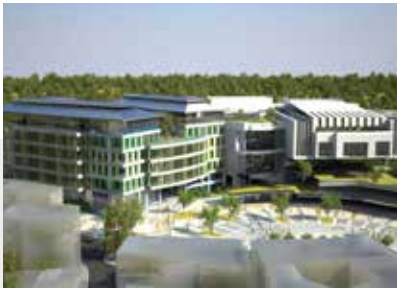
USKUDAR MUNICIPALITY SERVICE BUILDING
