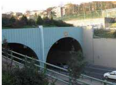
VECDI DIKER TUNNELS
