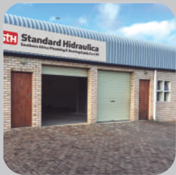
Sudáfrica (Port Elizabeth) Superficie 220 m2 Facilities / Installations
