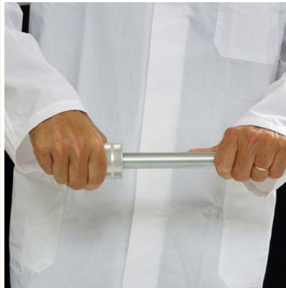
Fig. 22 | Entgraten der Rohrenden Pipe-end deburring
