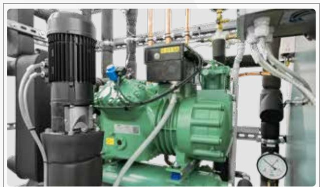
Stufenlos leistungsregelbarer Verdichter und frequenzgeregelte Hochleistungspumpe
