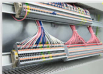
Übersichtliche Klemmleiste
